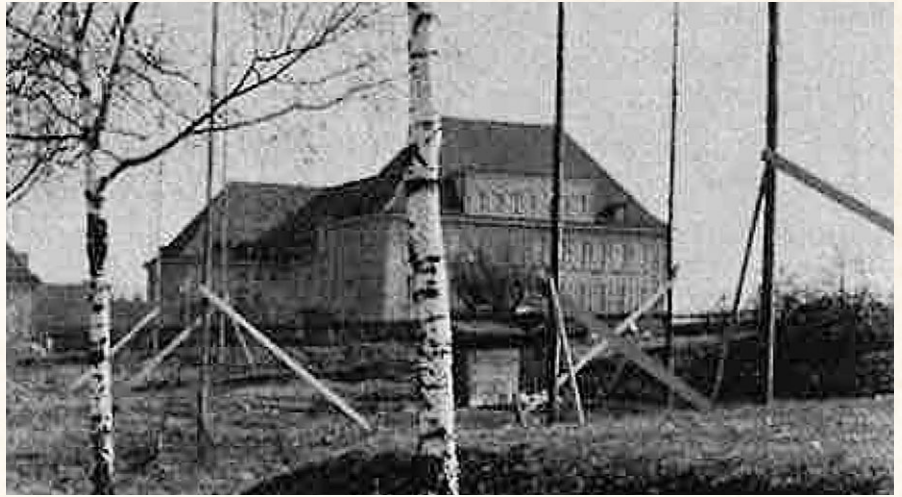
Kurz vor Beginn der Bauarbeiten im Jahre 1945
